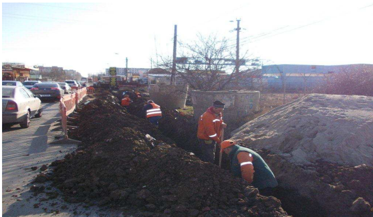
Extindere retea de alimentare cu apa potabila – 1,5 km Soseaua Prelungirea Ghencea
