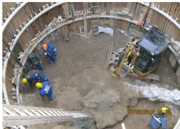
Extindere retea de canalizare cu sub - traversare apeducte prin metoda Pipe-jacking – 3,2 km Strada Dantelei
