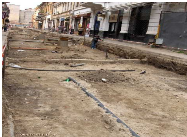
Reabilitarea rețelilor de alimentare cu apă și canalizare – 2 km Centrul Istoric
